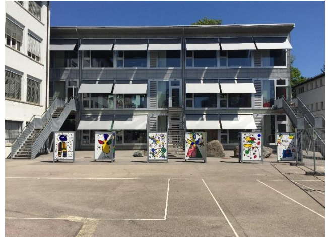
Pavillons avec surélévation en place
