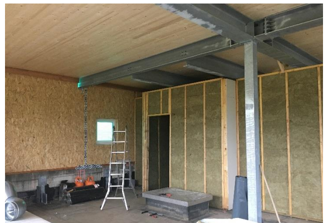
Dalle toiture en bois et parois légères
