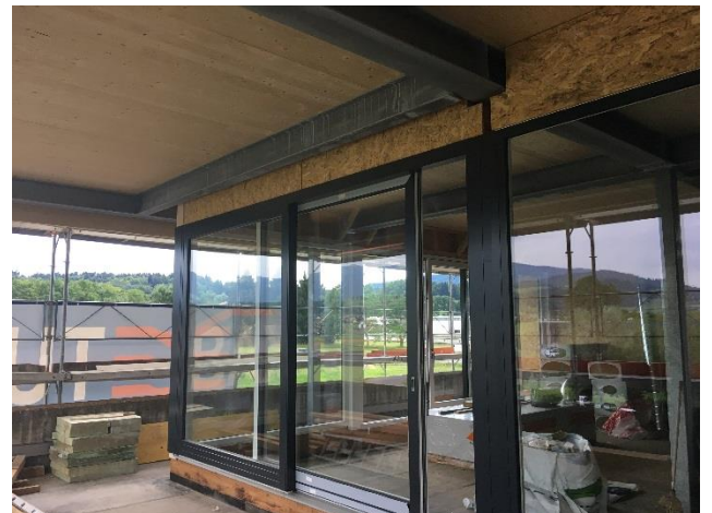
Surélévation avec structure mixte bois et acier
