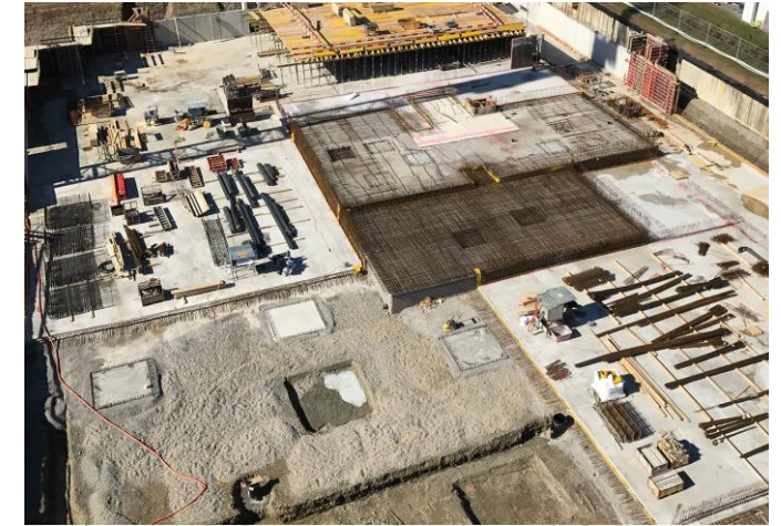
Bau der Bodenplatte
