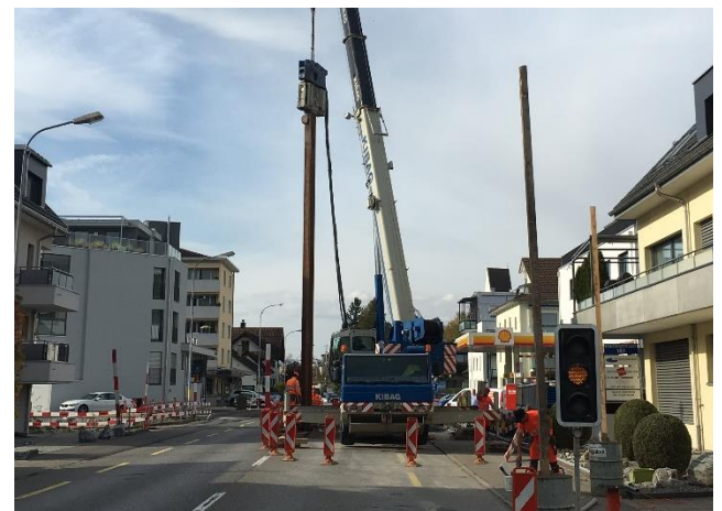
Spundwandarbeiten im Strassenbereich für Düker und Brücke Sarenbach
