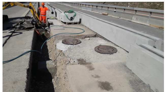
Trasse: Einbau Schlitzrinne Mittelstreifenüberfahrt
