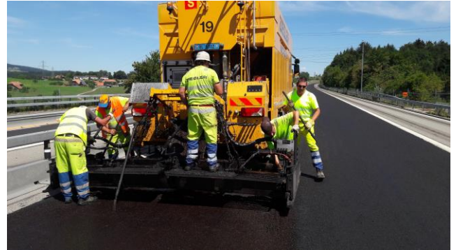
Trasse: Einbau 2. Schicht des Kaltmicrobelages
