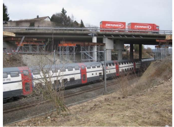
Unterführung Rucheggstr. / SBB A1
