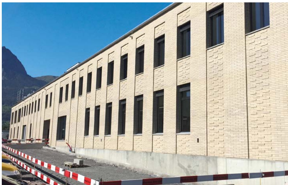
Die Bauweise mit Klinkersteinen ist zwar teurer, gibt der Käserei jedoch ein rustikales Aussehen.
