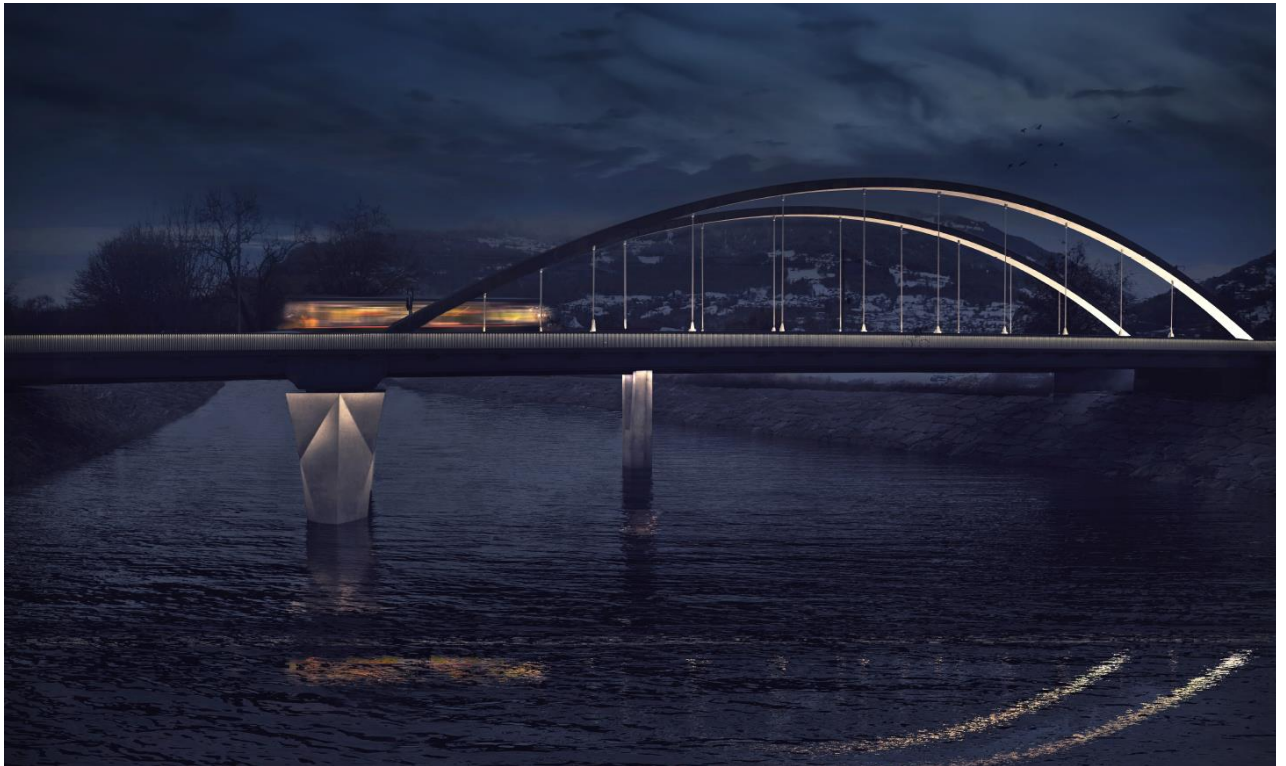
Pont sur le Rhône à St-Triphon
