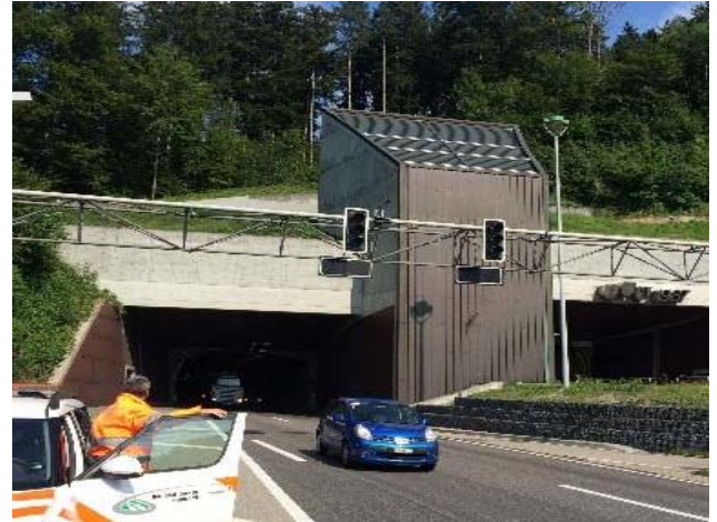
Portail Tunnel Rosenberg
