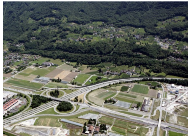
Bretelle autoroutier Bellinzona Sud
