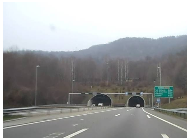
Südportal Ceneri Tunnel
