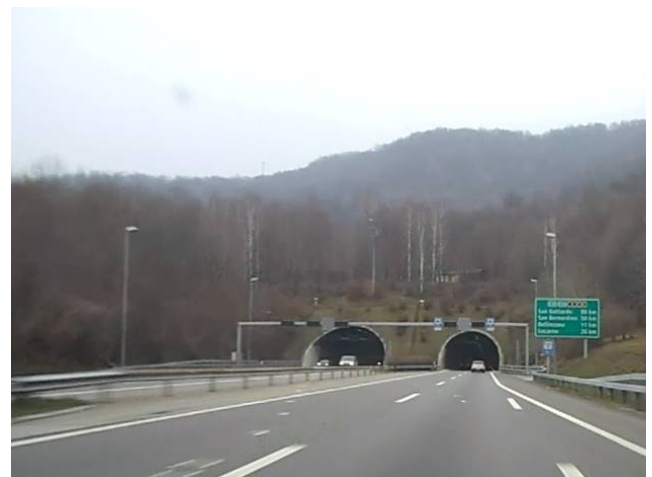
Südportal Ceneri Tunnel
